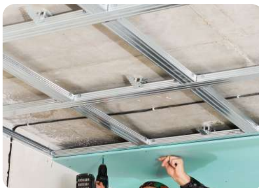
Tabiquería en Drywall
