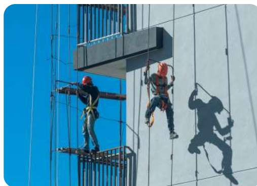
Trabajos de limpieza de altura
